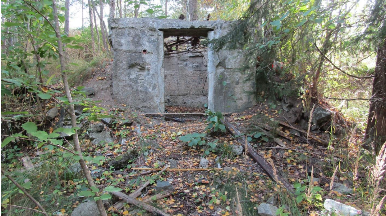
Foto 12: Potetkjelleren i Nordåsveien 173. Bildet er tatt mot ØSØ.
