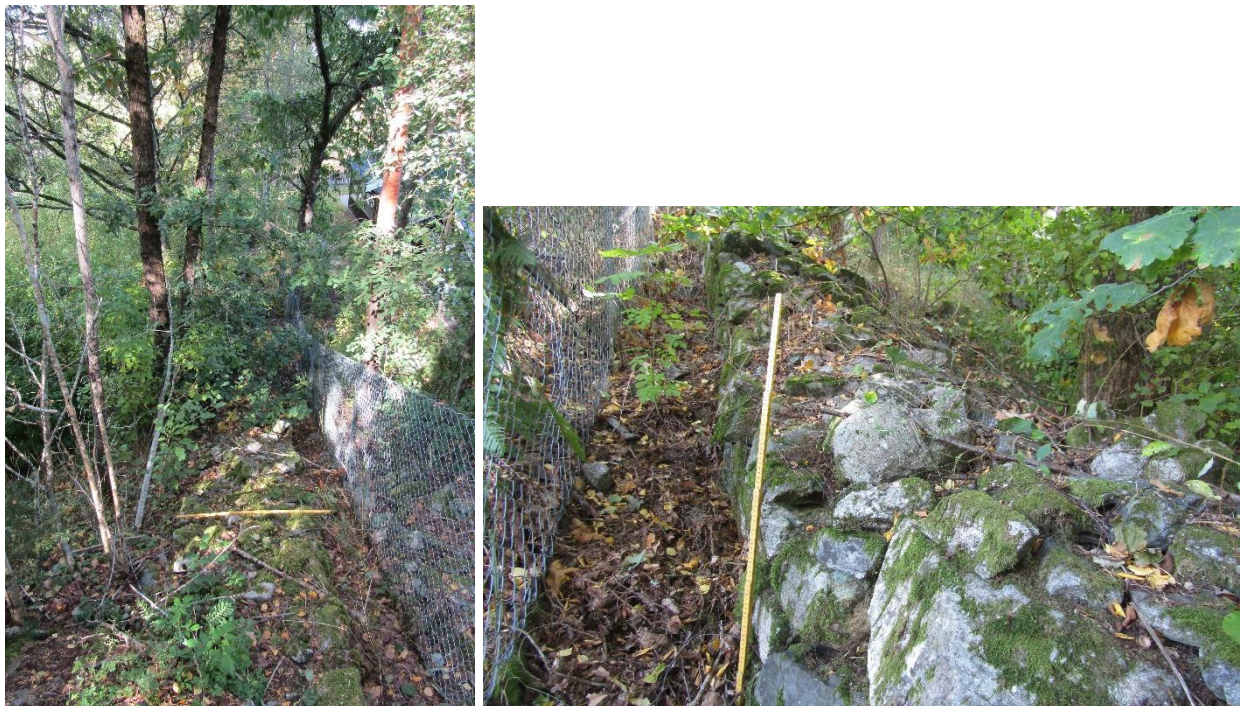
Foto 13: Stengjerdet mellom nr. 173 og 171. Bildet til venstre er tatt mot ØSØ og til høyre mot NV.
