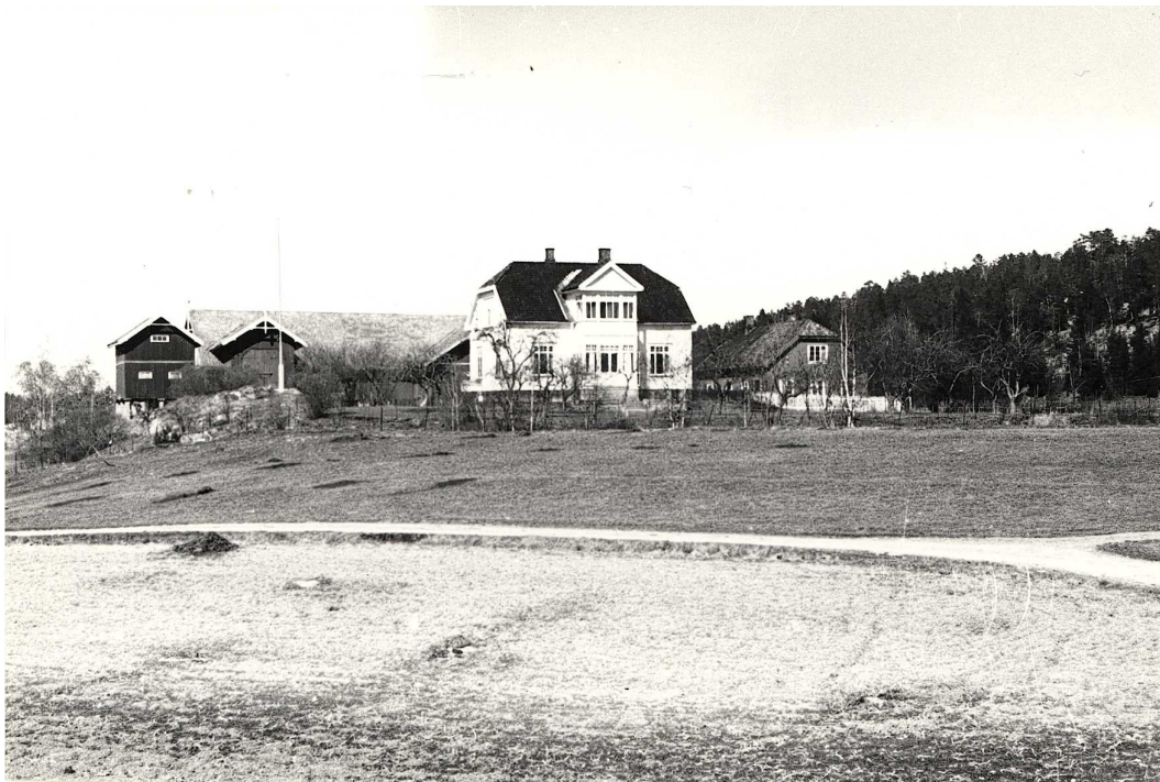
Holm gård, bildet er tatt mot nord/nordøst. Her sees våningshuset, bryggerhuset, stabburet og driftsbygningen
